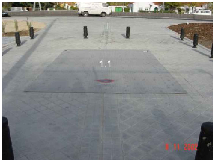
DETALLE TIPICO COMPUERTA SALIDA DE EMERGENCIA
