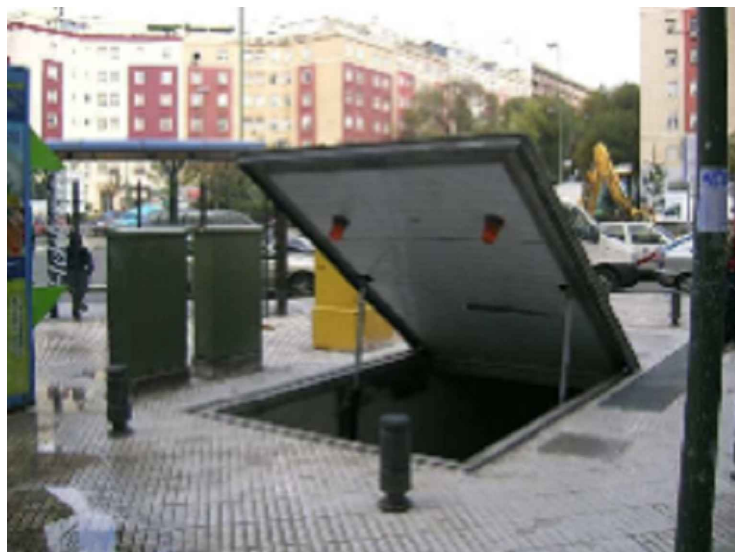
DETALLE TIPICO COMPUERTA SALIDA DE EMERGENCIA
