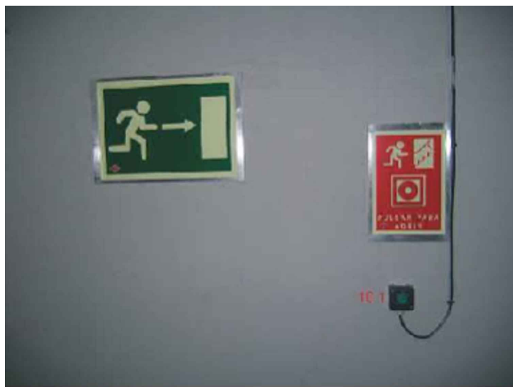
DETALLE TIPICO PULSADOR APERTURA COMPUERTA DE SALIDA
