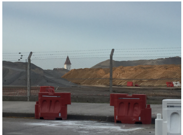
Obras en aeroparque, costanera norte, 2021
